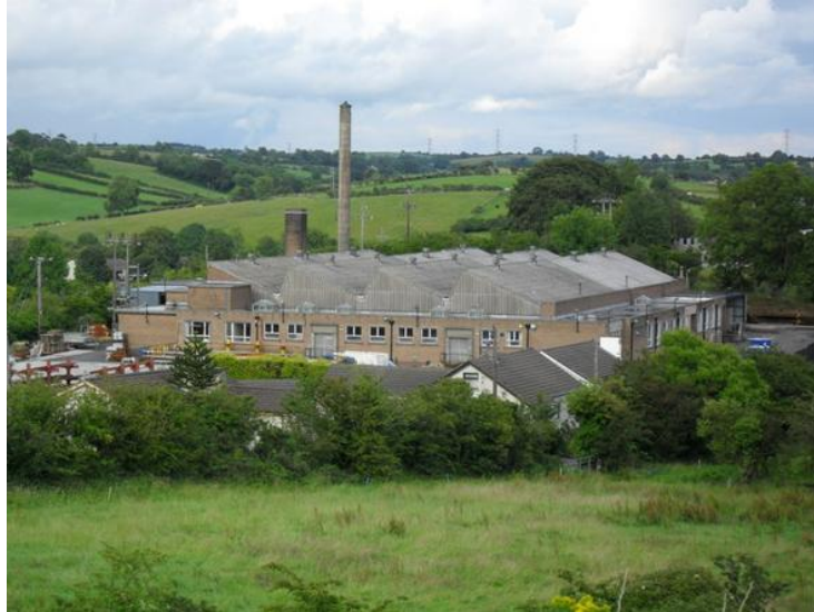
Kuva 1 Viisi ihmistä vietiin juustotehtaalta sairaalaan kemikaalivuodon johdosta.
